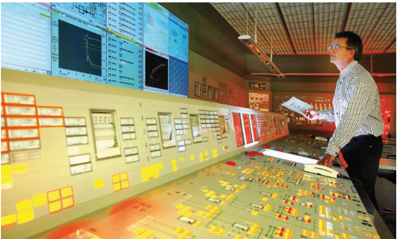
Leitstand eines Atomkraftwerks in der Kraftwerks-Simulator-Gesellschaft und der Gesellschaft für Simulatorschulung in Essen. Hier wird das Betriebspersonal der deutschen Atomkraftwerke aus- und fortgebildet.
